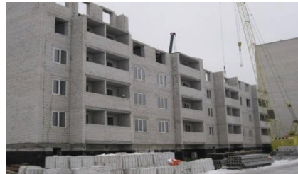
м. Чернігів, 80-квартирний будинок
