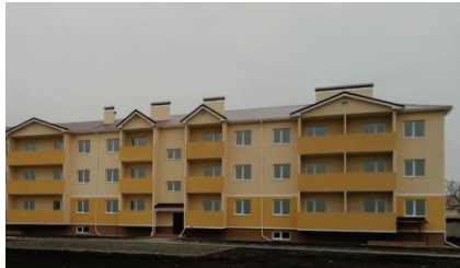
м. Бориспіль, 66-квартирний будинок
