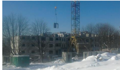
м. Київ, 167-квартирний будинок
