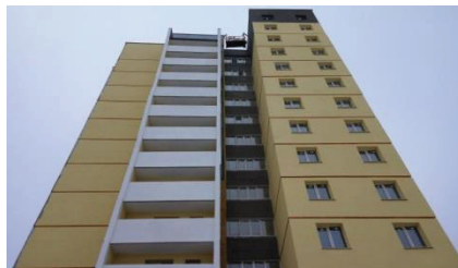
м. Житомир, 60-квартирний будинок
